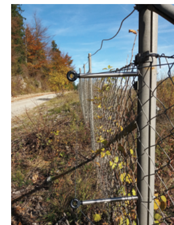
Električna ograja, nameščena na primorski avtocesti med Logatcem in Lomom za namene zmanjševanja povoz medveda in večje divjadi na avtocesti.
