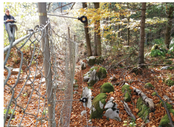
Električna ograja, nameščena na primorski avtocesti med Logatcem in Lomom za namene zmanjševanja povoz medveda in večje divjadi na avtocesti.
