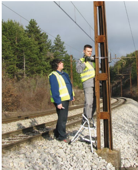
Akustische Abschreckanlagen werden an den Elektromasten montiert.
