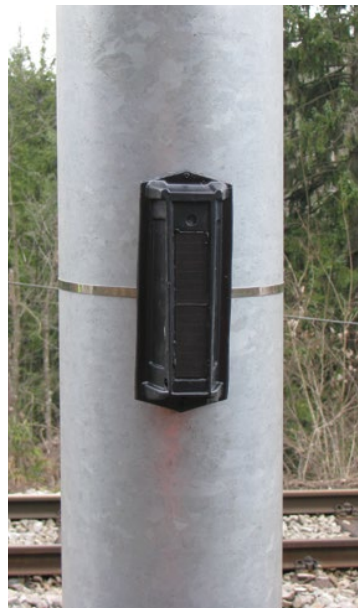
Akustische Abschreckanlagen werden an den Elektromasten montiert.
