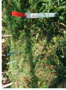
Ustrezna ozemljenitev je predpogoj za učinkovito delovanje elektromreže. (Foto: Tomaž Berce)
