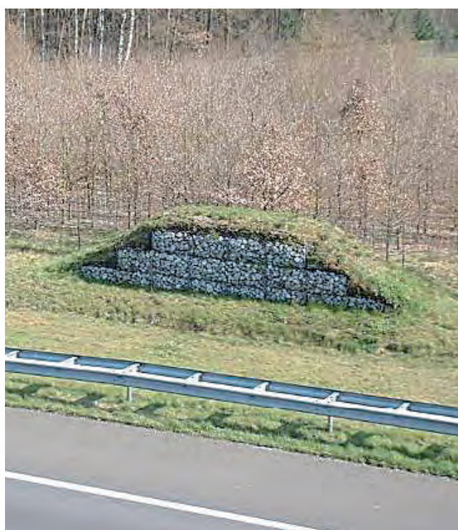
Slika 17. Kameno-zemljane iskočne rampe za jednostrani izlaz životinja iz ograđenog prostora autoceste.
