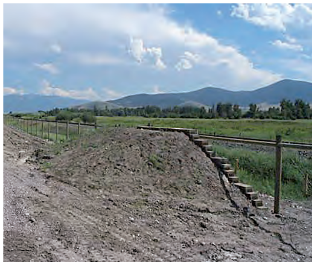
Slika 16. Kameno-zemljane iskočne rampe za jednostrani izlaz životinja iz ograđenog prostora autoceste.
