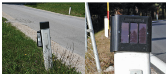
Dva tipa zvučnih plašilica koje su se do sada koristile u Sloveniji.
