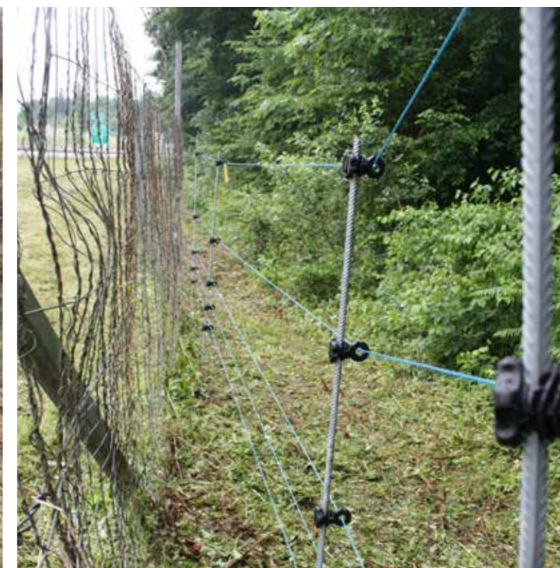
Postavljena jednosmjerna vrata za izlaz koja dopuštaju životinjama bijeg iz ograđene autoceste Rijeka – Zagreb (lijevo). Dodatak električne ograde osigurava zaštitu protiv medvjeda i navodi ih na sigurno mjesto prijelaza (desno). (Huber, Đ.)
