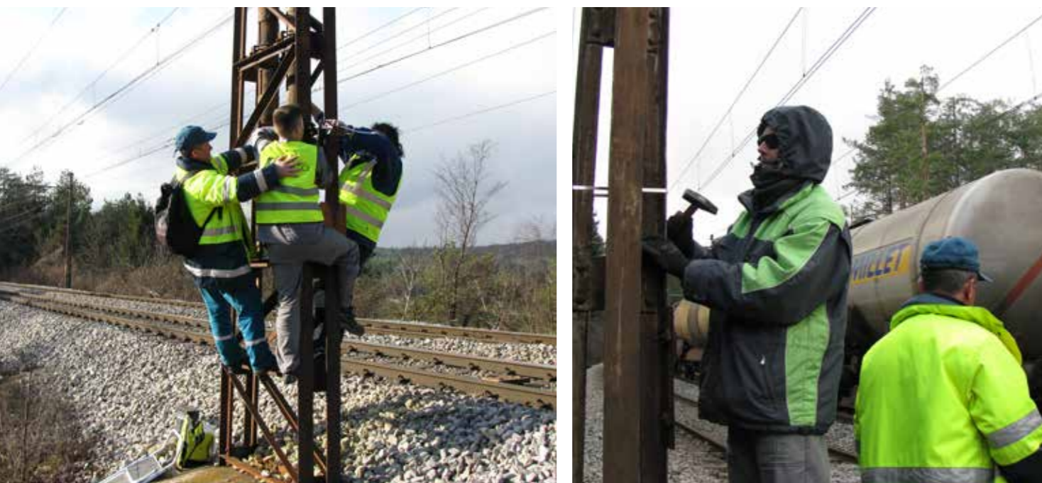
Postavljanje akustičnih sredstava za odvratanje na kritičnim točkama željezničke pruge Rakek – Postojna i Postojna – Prestranek. (Zaluberšek, M.)
