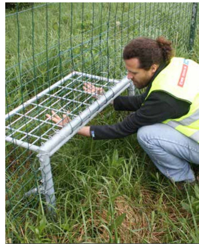
Jednosmjerna vrata i iskočne rampe koriste se kako bi životinje koje uspiju ući u ograđenu autocestu brzo i sigurno pronašle izlaz iz opasne zone. (Huber, Đ.)
