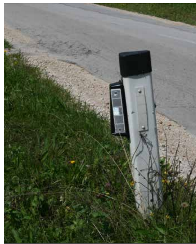
Akustična sredstva za odvratanje divljih životinja s područja cesta. Moguće ih je montirati na prometne znakove. (Zaluberšek, M.)
