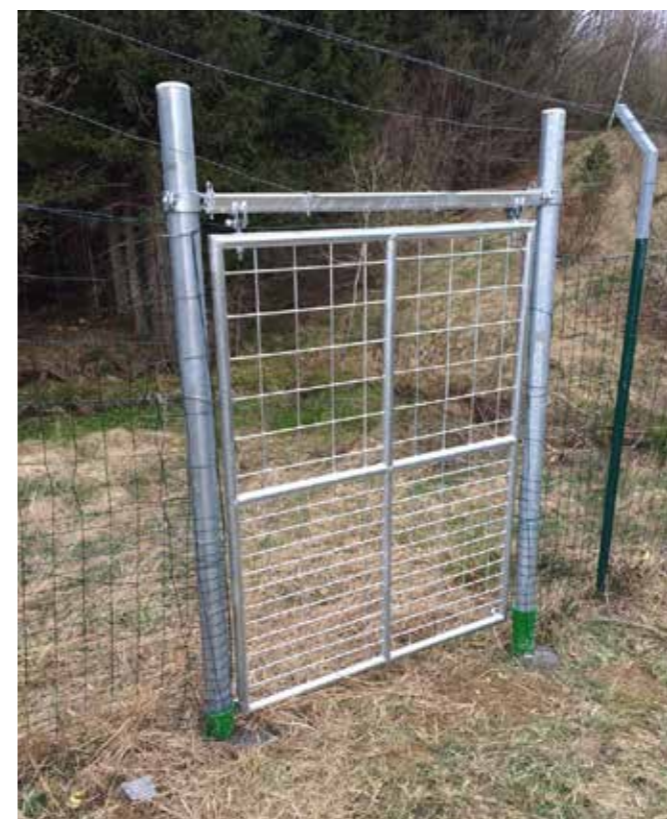
Postavljena jednosmjerna vrata za izlaz koja dopuštaju životinjama bijeg iz ograđene autoceste Rijeka – Zagreb (lijevo). Dodatak električne ograde osigurava zaštitu protiv medvjeda i navodi ih na sigurno mjesto prijelaza (desno). (Huber, Đ.)
