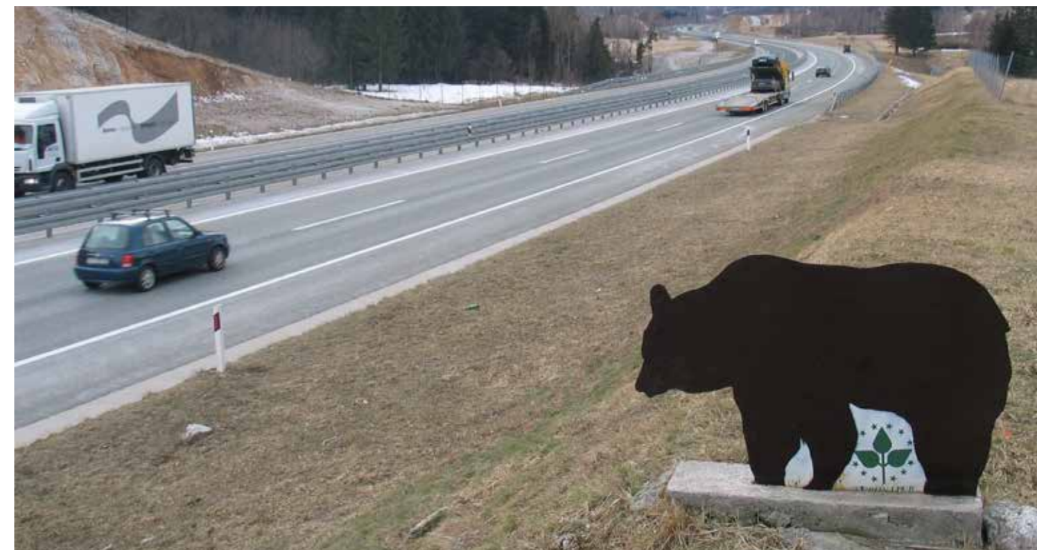
Moderna hrvatska autocesta ima relativno dobru propusnost za velike sisavce zbog raznovrsnosti reljefa i posljedično velikog broja tunela i vijadukata, ali i zbog modernog pristupa zaštiti prirode tijekom planiranja mjera za ublažavanje. (Huber, Đ.)
