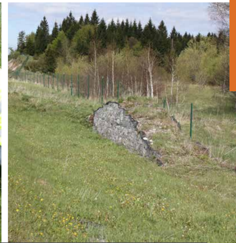
Jednosmjerna vrata i iskočne rampe koriste se kako bi životinje koje uspiju ući u ograđenu autocestu brzo i sigurno pronašle izlaz iz opasne zone. (Huber, Đ.)
