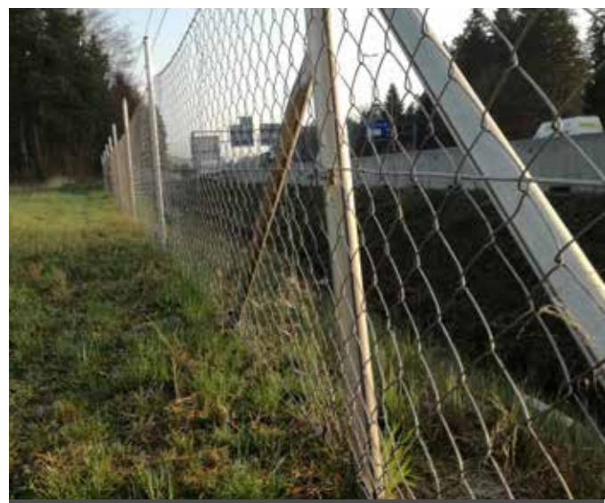
Sve autoceste u Sloveniji i Hrvatskoj ograđene su 160 cm visokom ogradom. Na kritičnim dijelovima, na kojima je stalno prisutan medvjed, električna ograda može se dodati kako bi spriječila prelazak medvjeda. (Potočnik, H.)
