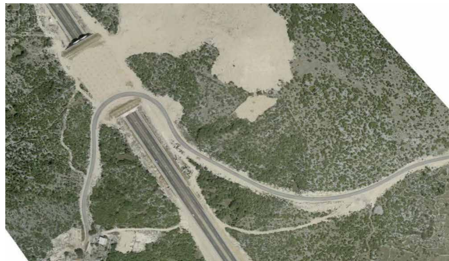
Primjer neodgovarajuće izgradnje zelenog mosta (Vrankovića ograda, Hrvatska) gdje je lokalna cesta sagrađena preko prijelaza kako bi se spojilo selo s druge strane autoceste. Trebalo je sagrađiti odvojeni nadvožnjak za cestu.
