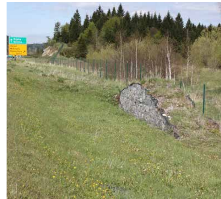
Ukrepi s katerimi omogočimo/olajšamo pobeg živali iz ograjenih površin prometnic, kot so enosmerna izhodna vrata in izskočne rampe, zmanjšujemo verjetnost za trk z vozili. (Huber Đ.)
