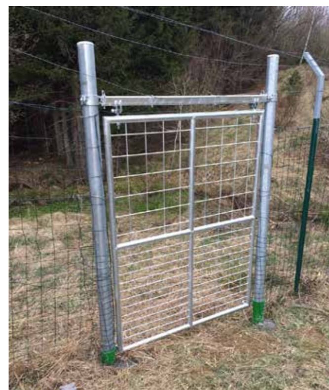
Levo: Z vgraditvijo enosmernih izstopnih vrat za pobeg živali iz ograjenih površin na avtocesti Zagreb – Reka so dodatno poskrbeli za povečanje prometne varnosti. Desno: Nameščanje električnih ograj preprečuje prehajanje medvedov preko zaščitne ograje/mreže in jih usmerja na varne prehode. (Huber Đ.)
