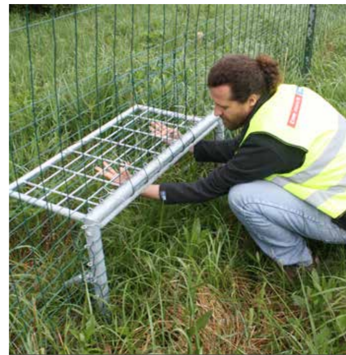
Ukrepi s katerimi omogočimo/olajšamo pobeg živali iz ograjenih površin prometnic, kot so enosmerna izhodna vrata in izskočne rampe, zmanjšujemo verjetnost za trk z vozili. (Huber Đ.)
