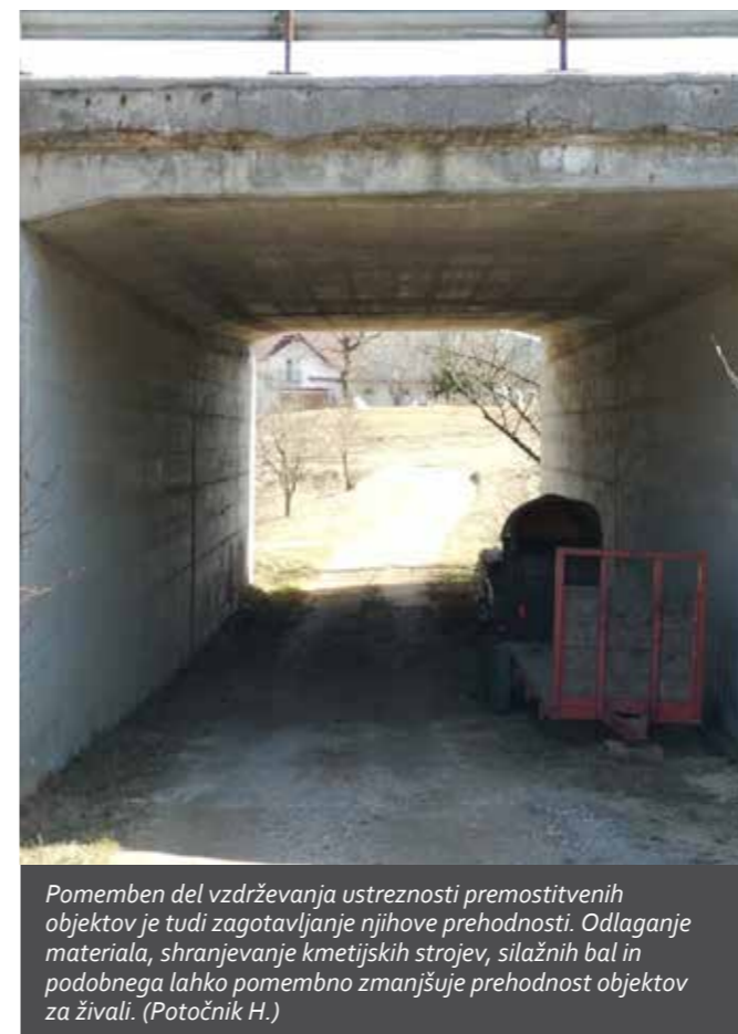
Prehodnost podhodov za velike sesalce je poleg lokacije odvisna tudi od širine, višine in dolžine objekta, oziroma t.i. indeksa odprtosti. Levo: Podvoz z nizim indeksom odprtosti je neprimeren za prehajanje nekaterih vrst velikih sesalcev. (Črtalič J.) Desno: Podvoz pod katerim poteka tudi potok, cesta je umeščena ob robu podhoda/podvoza. (Potočnik H.)
