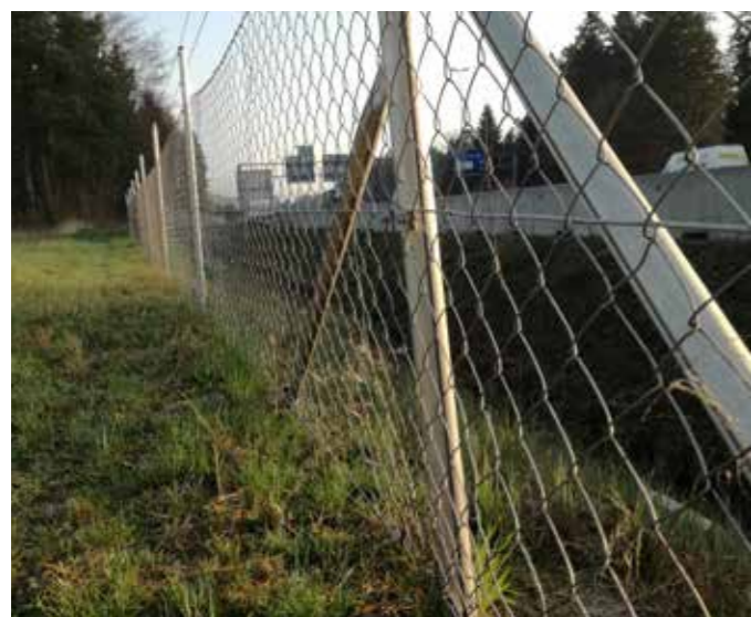
Vse avtoceste v Sloveniji in na Hrvaškem so zaradi zagotavljanja prometne varnosti ograjene z vsaj 160 cm visoko ograjo. Na nekaterih kritičnih odsekih jo zaradi zadrževanja medvedov dopolnjuje še električna ograja. (Potočnik H.)
