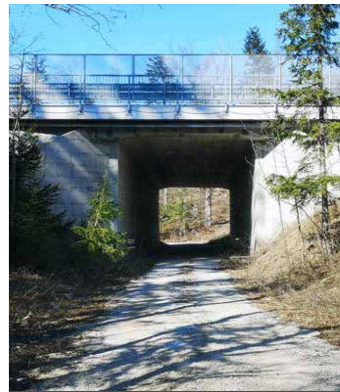
Prehodnost podhodov za velike sesalce je poleg lokacije odvisna tudi od širine, višine in dolžine objekta, oziroma t.i. indeksa odprtosti. Levo: Podvoz z nizim indeksom odprtosti je neprimeren za prehajanje nekaterih vrst velikih sesalcev. (Črtalič J.) Desno: Podvoz pod katerim poteka tudi potok, cesta je umeščena ob robu podhoda/podvoza. (Potočnik H.)
