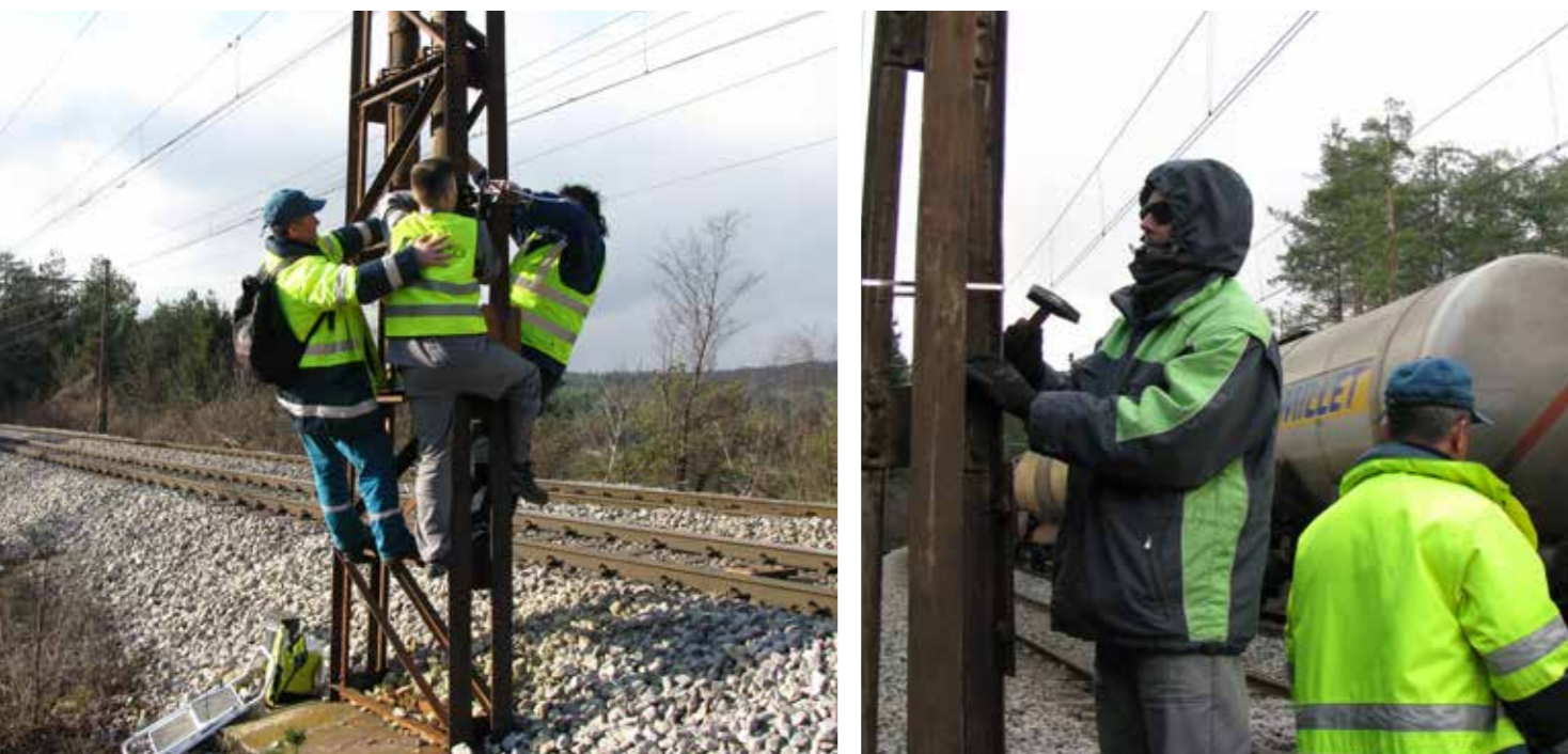
Postavljanje zvočnih odvrčal na kritičnih odsekih železnice na relaciji Rakek – Postojna in Postojna – Prestranek. (Zaluberšek M.)
