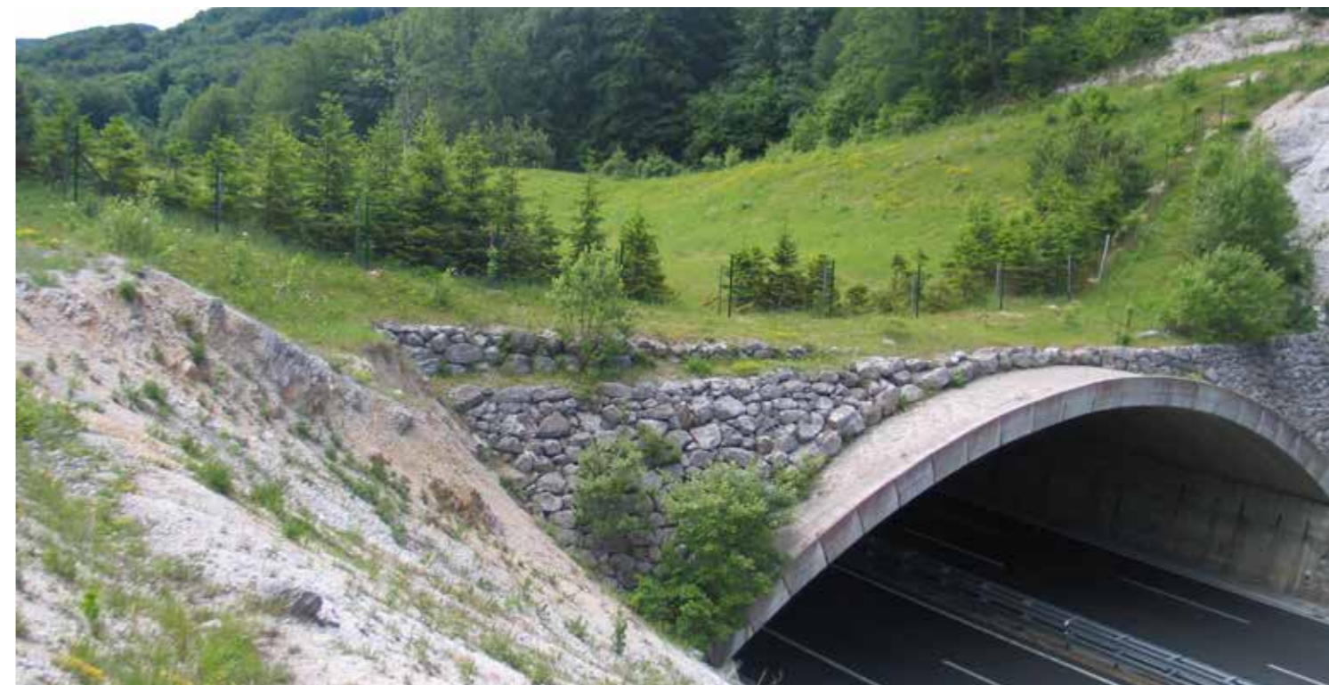
Ustrezno umeščeni zeleni mostovi so med najučinkovitejšimi premostitvenimi objekti za zmanjševanje fragmentacije prostora velikih sesalcev, zlasti velikih zveri. (Huber Đ.)
