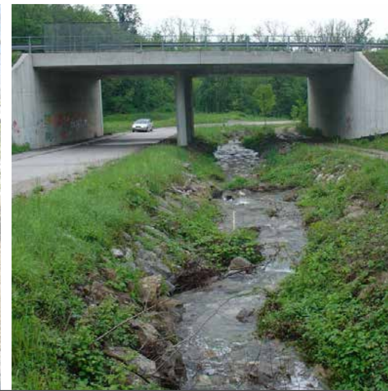
Prehodnost podhodov za velike sesalce je poleg lokacije odvisna tudi od širine, višine in dolžine objekta, oziroma t.i. indeksa odprtosti. Levo: Podvoz z nizim indeksom odprtosti je neprimeren za prehajanje nekaterih vrst velikih sesalcev. (Črtalič J.) Desno: Podvoz pod katerim poteka tudi potok, cesta je umeščena ob robu podhoda/podvoza. (Potočnik H.)
