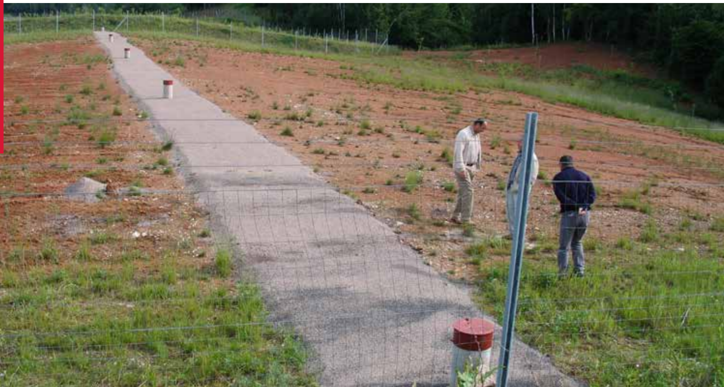
Peščene blazine na zelenih mostovih običajno kombinirajo s senzorji prehajanja živali, ki omogočajo vrednotenje pogostosti prehajanja posameznih živalskih vrst, katerih sledove evidentirajo v pesku. (Huber Đ.)
