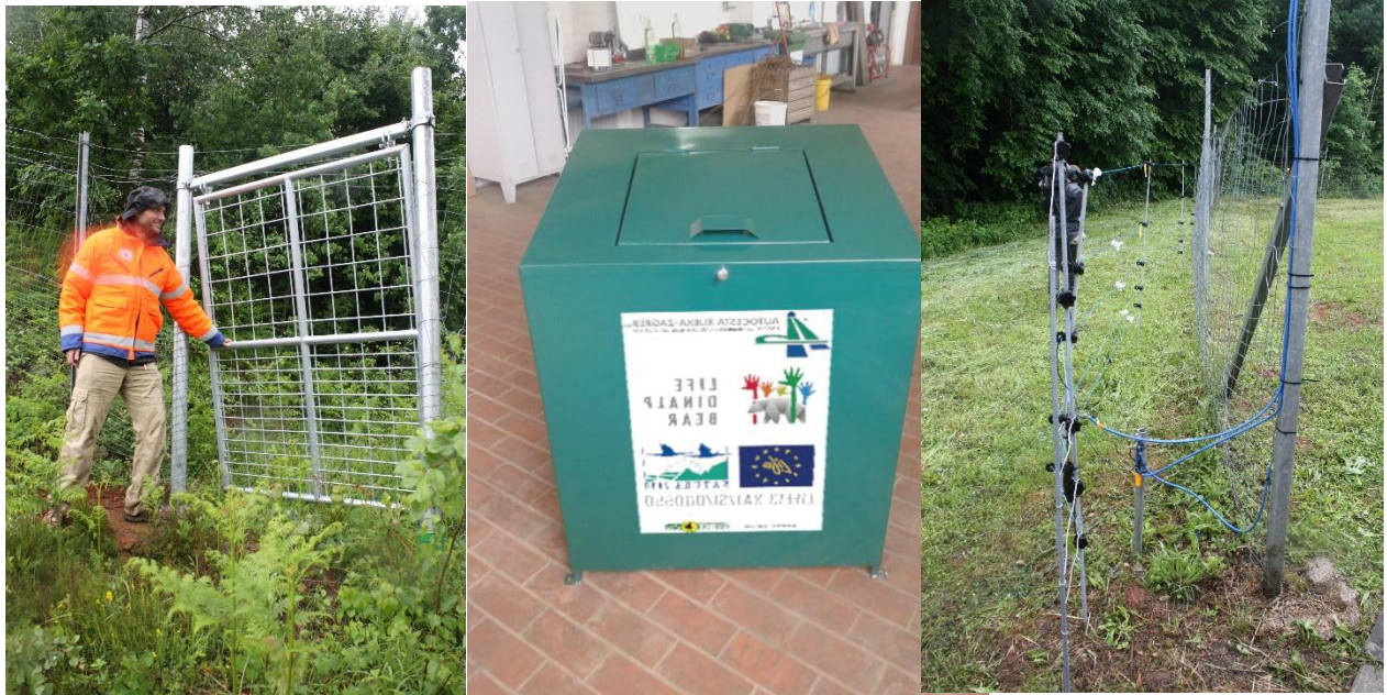
Jednosmjerna vrata, spremnik za otpad „otporan“ na medvjede i električna ograda uz mrežu na autocesti Rijeka – Zagreb Foto: Đuro Huber, Bojan Vivoda i Slaven Reljić
