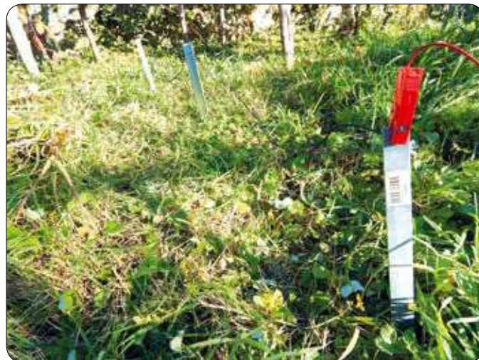
Ustrezna ozemljitev je predpogoj za učinkovito delovanje elektromreže. (Foto: Tomaž Berce)
